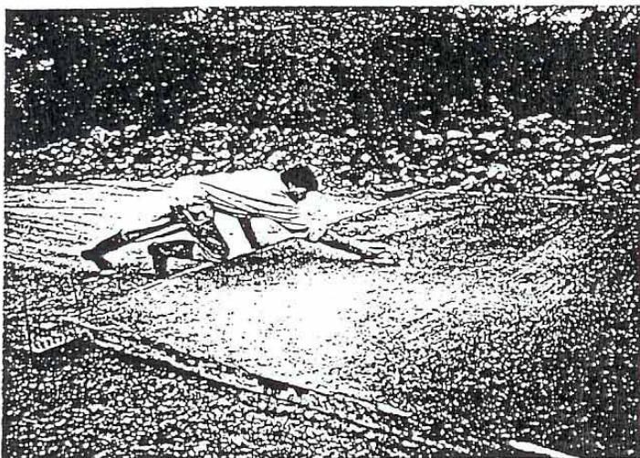
Figura 41: Correcció de defectes locals amb la llana.
