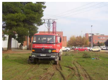
Fotografia 8: Emplaçament sondeig S-6
