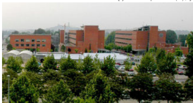
Al campus d'ETSEA s'ubicaran tres de les cinc instal·lacions fotovoltaïques
